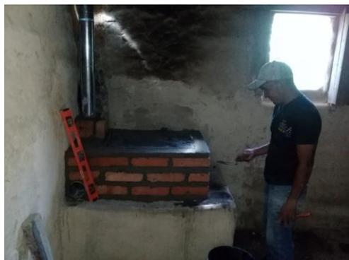
**Figura 11. Finalización de construcción de estufa mejorada.**
